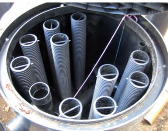
*Blick in den Filterschacht mit gelöcherten Rohren, die mit Filterstrümpfen überzogen werden*
