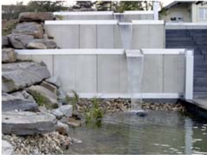
links: Wassertreppe an einer Schwimmteichanlage in Herzogenrath, Bau Herbst 2005, Fotoaufnahme vom 21.12.2005
